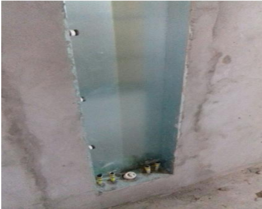
Foto 17: Montagem das caixas do sistema de Gás .
