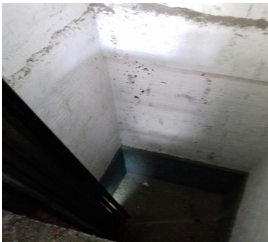
Foto 16: Início da montagem do elevador.
