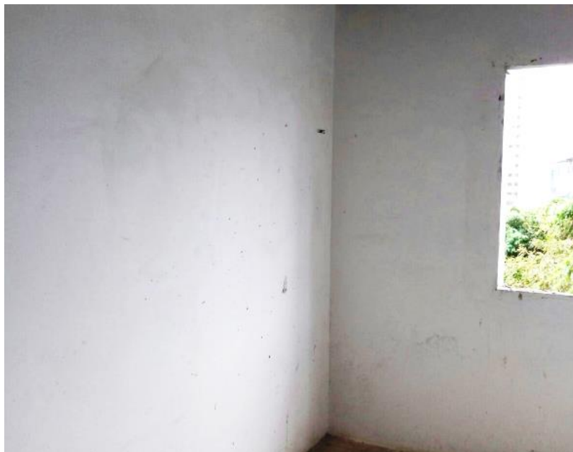
Foto 8: Conclusão do Gesso nos pavimentos.
