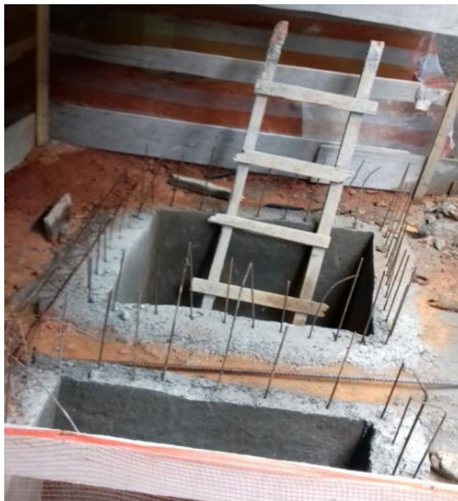
Foto 11: Implantação dos sistemas fluviais e de esgoto .
