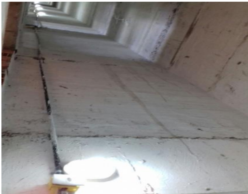
Foto 15: Tratamento do poço do elevador
