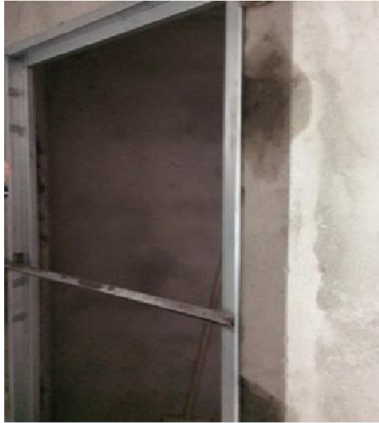
Foto 7: Assentamento das esquadrias das Portas Corta Fogo.
