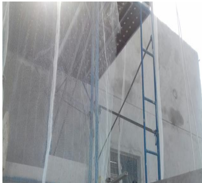
Foto 10: Andamento da massa da cobertura.
