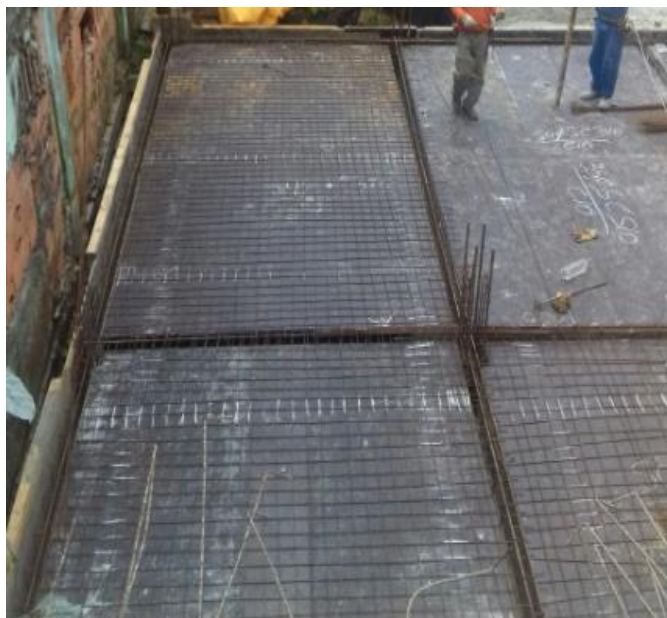
Foto 12: Montagem das ferragens para a concretagem da Garagem 1 (G1).
