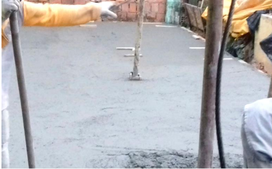
Foto 13: Concretagem da Garagem 1 (G1).
