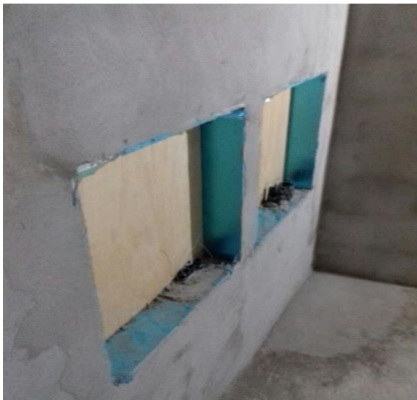
Foto 18: Montagem das caixas do sistema elétrico e de telefone .
