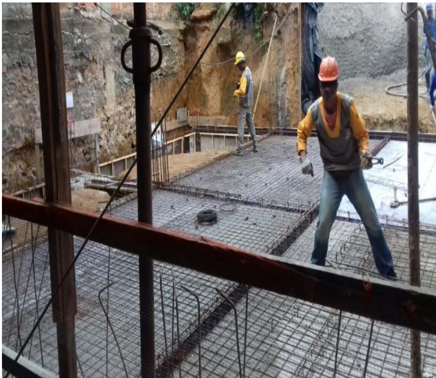
Foto 14: Montagem das ferragens para a concretagem Garagem 2 (G2).
