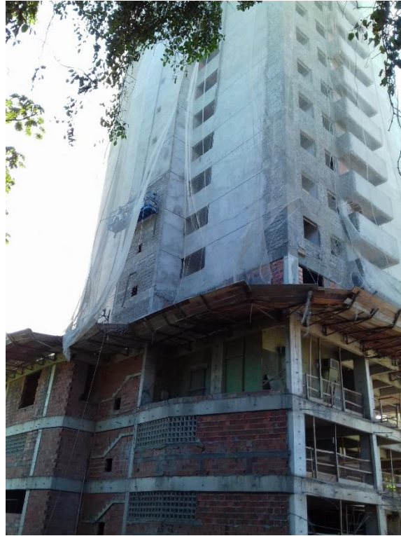
Foto3: Andamento da massa da Fachada 3 .
