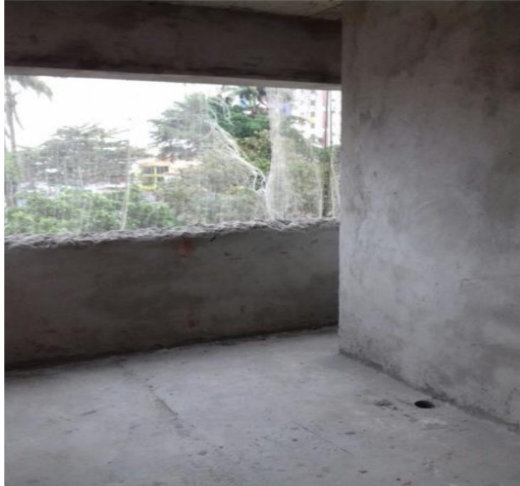
Foto 9: Execução da massa das varandas.
