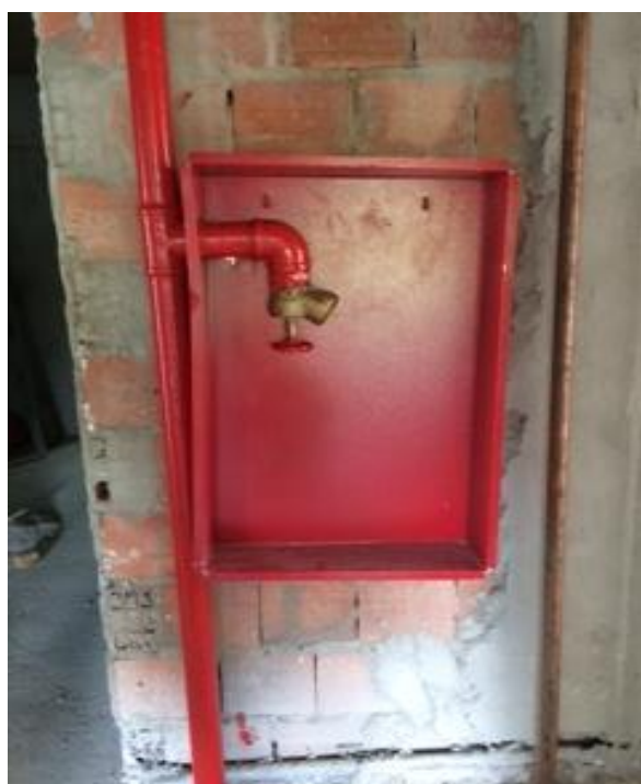
Foto 6 : Motagem do sistema de incendio
