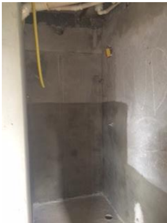
Foto 5: Aplicação da Impermeabilização das areas molhadas.
