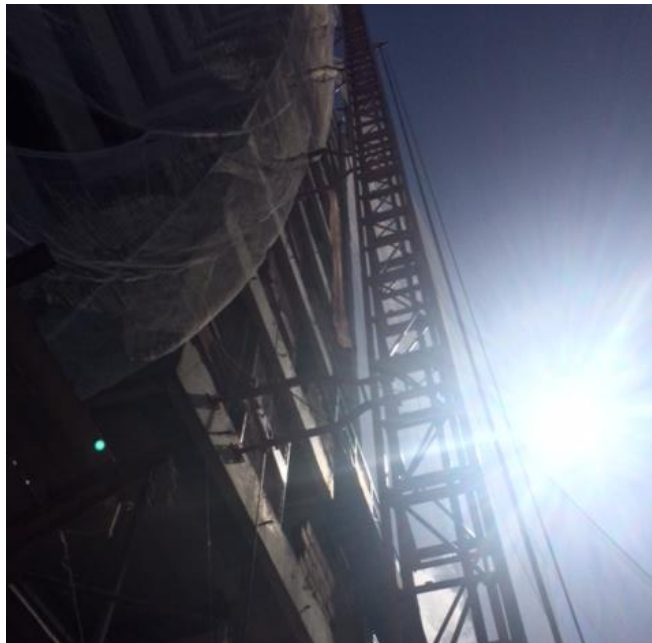
Foto 8: Conclusão da montagem do elevador tipo cremalheira
