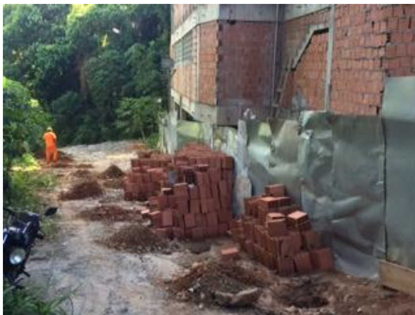
Foto 15: Início da execução do muro limite da obra
