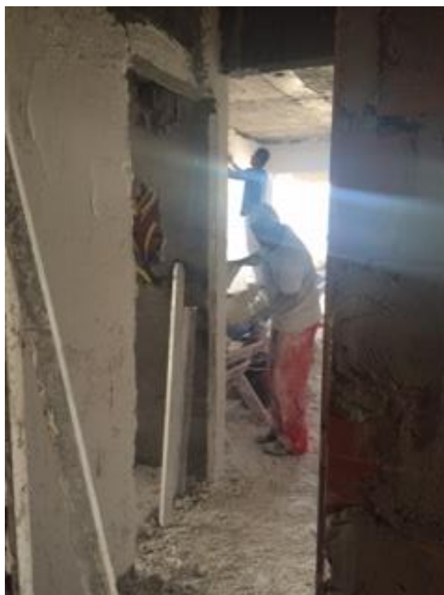
Foto 13: Início da execução de gesso corrido
