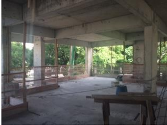
Foto 4: Limpeza e proteções de segurança
