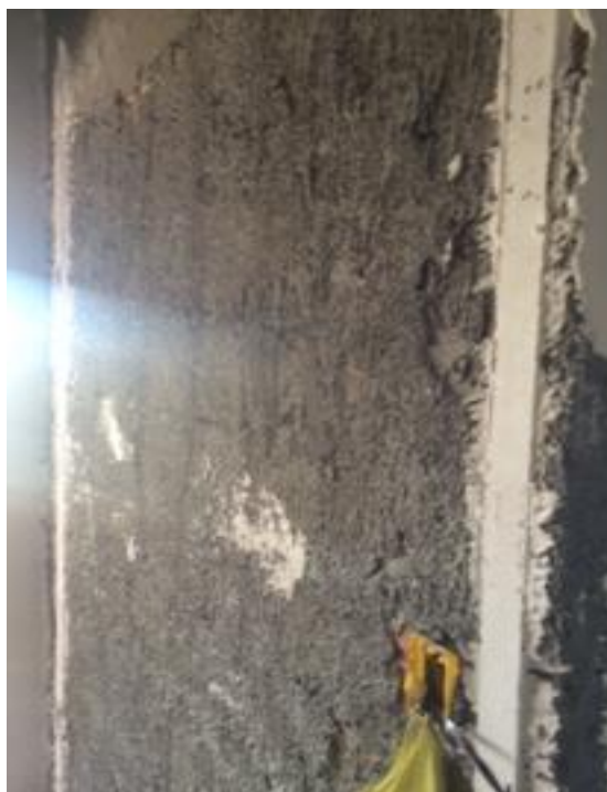
Foto 11: Execução de mestra para gesso
