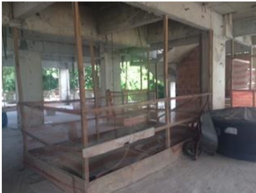
Foto 5: Limpeza e proteções de segurança
