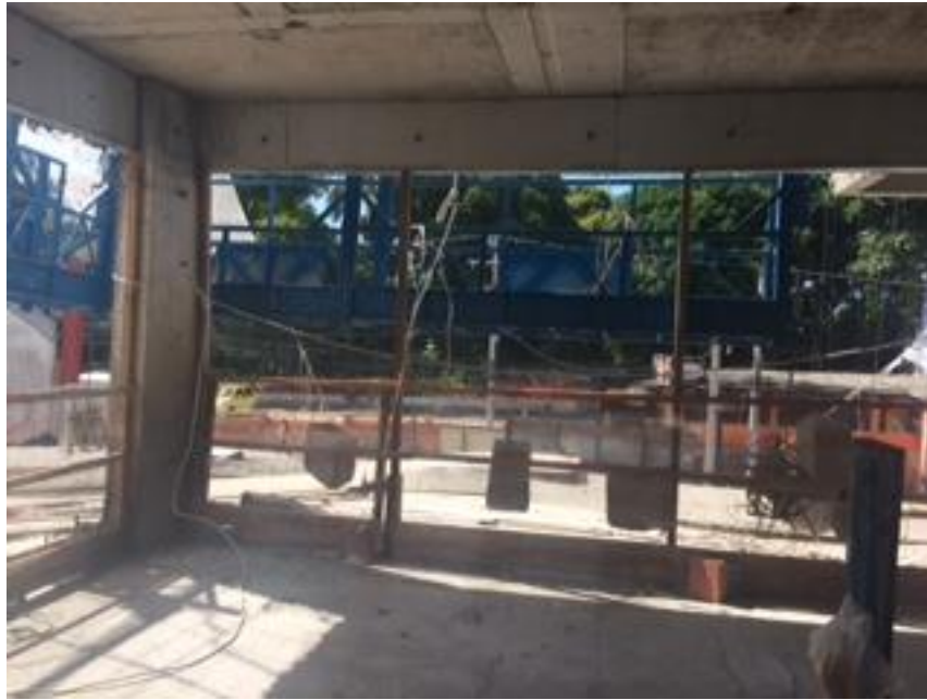
Foto 2: Adequação de prumos da fachada
