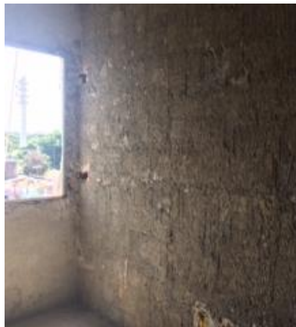
Foto 12: Execução de chapisco rolado nas paredes internas
