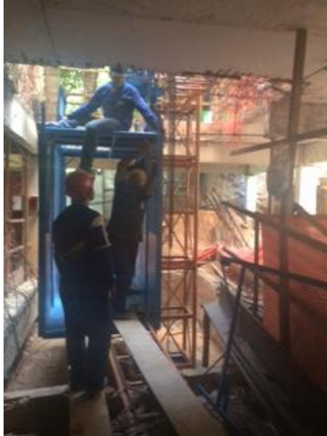
Foto 7: Início da montagem do elevador tipo cremalheira
