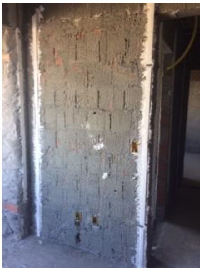
Foto 12: Execução de chapisco rolado nas paredes internas
