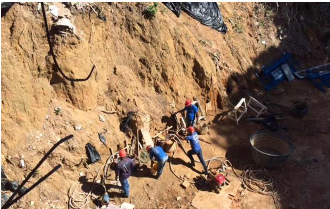
Foto 14: Início da execução da contenção
